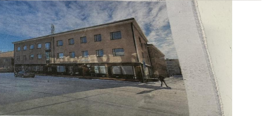
Vanha Etelä-Pohjanmaan puhelinyhtiön keskustalo sijaitsee Seinäjoella Puskantien ja Työväenkadun kulmassa. Nykyään sen omistaa Loihde.
